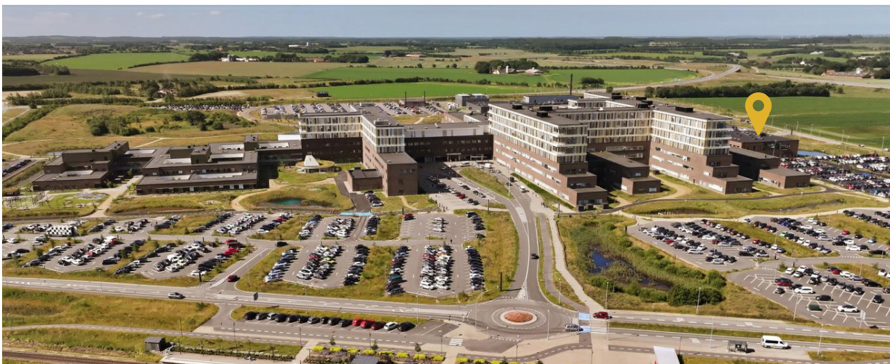
Regionshospitalet Gødstrup bedriver forskning inden for en bred vifte af områder, primært med udgangspunkt i hospitalets patienter. En stor del af hospitalets forskning er samlet i NIDO | Center for Forskning og Uddannelse i den nordvestlige ende af hospitalet (markeret med navigeringsikon). Foto: Region Midtjylland.
